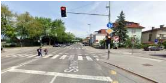
E) Križišče Samova ulica-Vodovodna cesta
